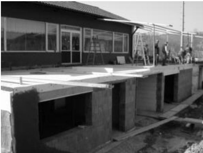
Umbau – Unterkellerung der Terrasse 2002
